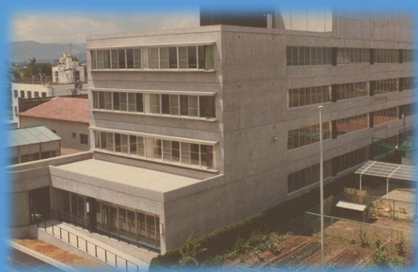
岐阜リハビリテーション専門学院 校舎完成 （昭和61年）
